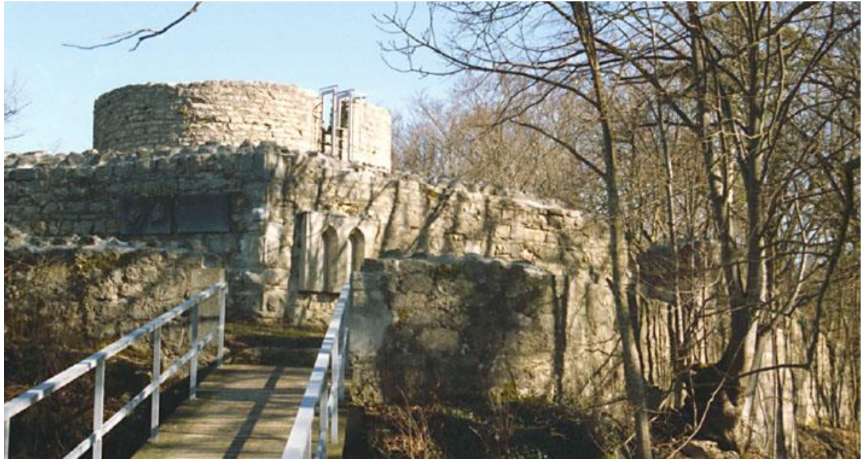
Zwingeranlage, Toranlage und Turm (März 2010)
